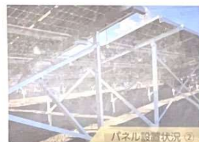
パネル設置状況②
